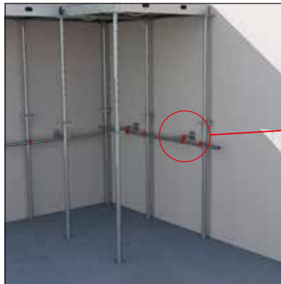
- Mettre en place la stabilisation des premiers éléments. - Lorsqu'elle est en place, il est possible de retirer les trépieds.
