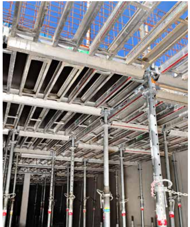
20 000 m 2 de surfaces de dalles
