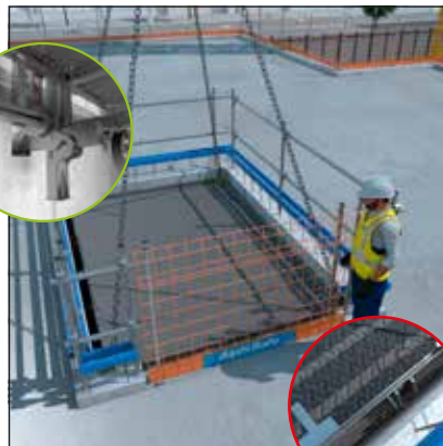
- Grâce aux tôles latérales qui se relèvent automatiquement quand le Podium est élingué, vérifier la bonne mise en place des rochets dans les réservations prévues.
