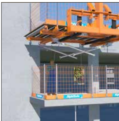
- Guider l'approche à l'aide des cordes présentes en bout de fourches.
