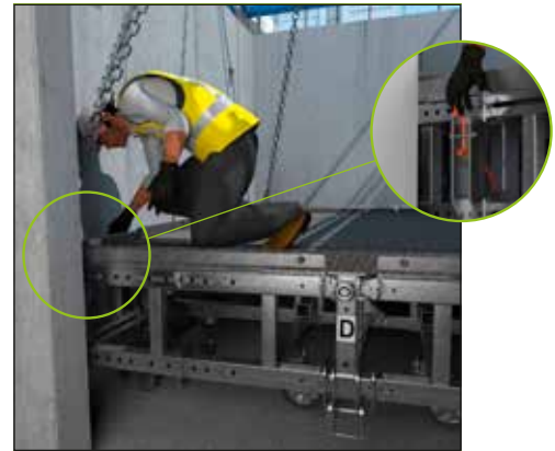
- Procéder au débloquage des rochets. - Soulever le Podium pour mettre en place les rochets dans les réservations murales.
