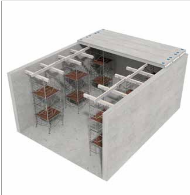
-Étaiment de dalles alveolaires avec des poutrelles AL200.
