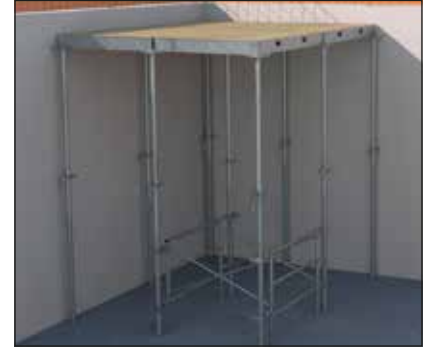
- Un cadre à croisillons est installé sur les 4 premiers étais en phase provisoire.
