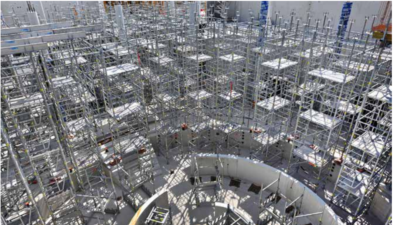
Un étaieement jusqu'à 8 m de hauteur
