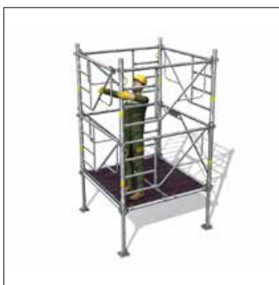
- Pose de 2 planchers à trappe de 1 m et montage du 2 e niveau.
