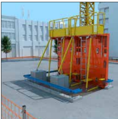
- Procéder au coffrage des murs.
