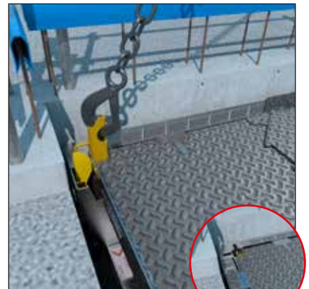
- Procéder au désélingage : le crochet de levage se rétracte et les tôles latérales se rabattent automatiquement.
