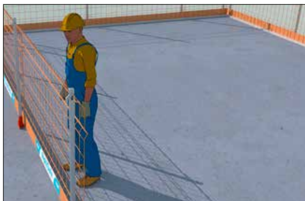
- La grille est verrouillée en tête par l'ergot anti-soulèvement et bloquée en pied.
