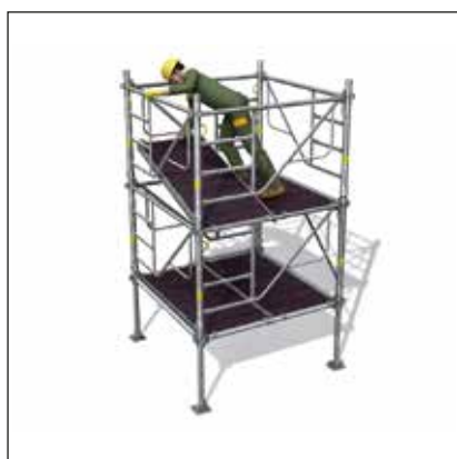
- Accès au niveau supérieur puis pose du 2 e plancher à trappe.
